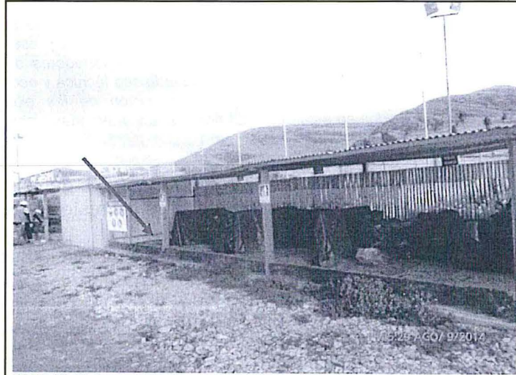
FOTO N° 27: Levantamiento de Hallazgo 5, Supervisión Especial 2014: Se retiró los residuos peligrosos (filtros, baldes, etc.) del almacén de residuos sólidos comunes llevándolos al lugar correspondiente.
