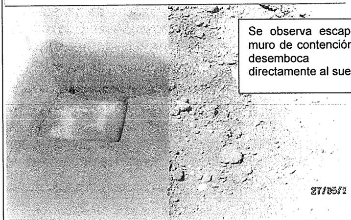
Se observa escape de muro de contención que desemboca directamente al suelo.
