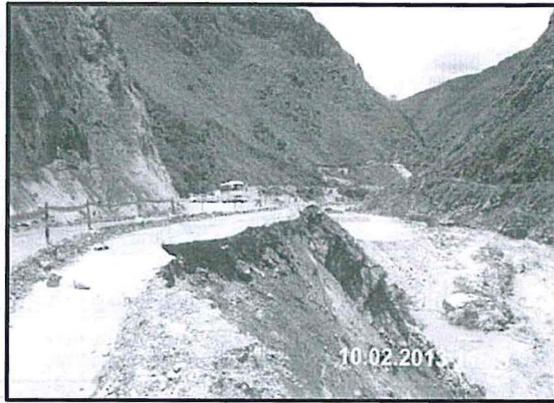
**Descripción:** Daño ocasionado en la plataforma por desprendimiento de talud de sostenimiento de la carretera Tramo 1
