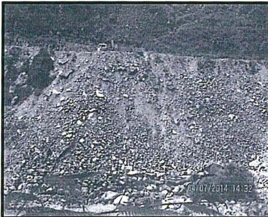
**Descripción:** El talud de material excedente presenta deslizamientos por inestable.
