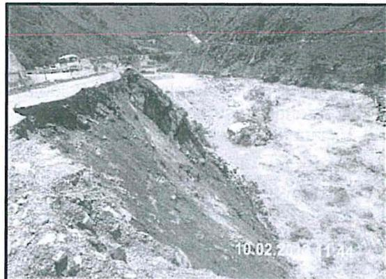
**Descripción:** Daño ocasionado al talud de sostenimiento de la carretera Tramo 1.
