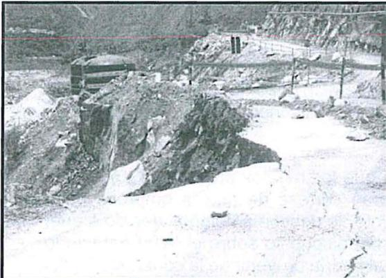
**Descripción:** Daño ocasionado en la plataforma por desprendimiento del talud de sostenimiento de la carretera Tramo 1
