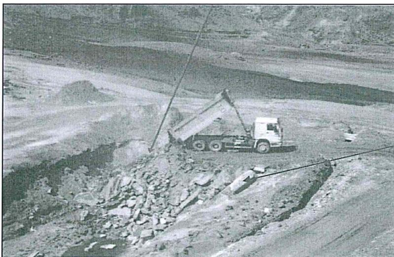
Disposición de desmonte en el sector del depósito de relaves
