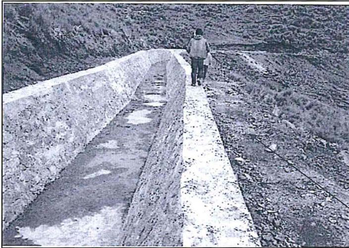
Construcción del canal de coronación de la margen derecha del depósito de relaves Chanca
