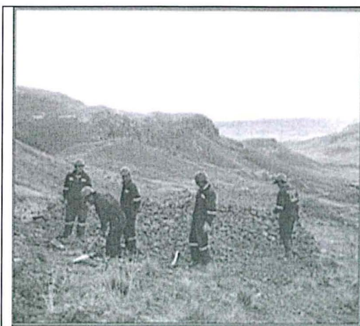
Fotografía N° 32: Vista del aflojamiento del suelo en las plataformas de perforación, de acuerdo a las ctividades de rehabilitación de las mismas.
