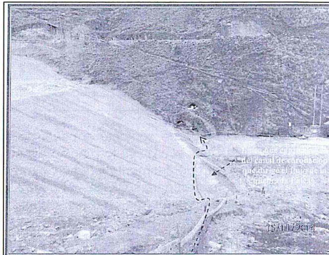
Fotografía N° 25: Hallazgo N° 2 en esta vista se observa la línea de HDPE de 4 pulgadas que capta el agua de la quebrada Palcas y es dirigido hacia la bocamina Nivel 580.
