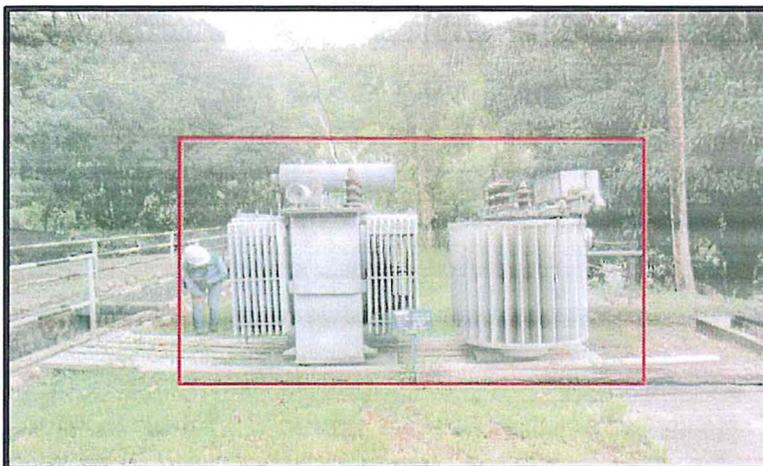
**Descripción:** Se evidencia dentro de las instalaciones de la CH Pichanaki, dos transformadores de potencia de 750 kVA y 450 kVA, ubicados sobre maderas y sobre el suelo natural.
