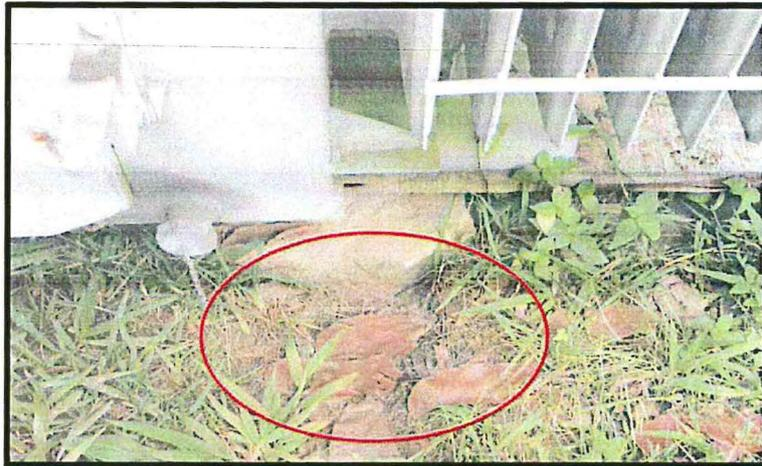
**Descripción:** Se observa el derrame de aceite dieléctrico de uno de los transformadores hacia el suelo natural.
