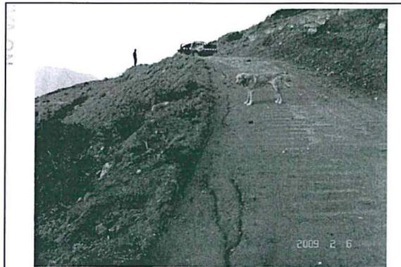
Foto 56: Se observa grietas profundas en la vía de acceso que conduce a los sondajes AE-IDA-DDH-08-15, AE-IDA-DDH-08-08 y AE-IDA-DDH-07-14 (Plataforma N° 4)
