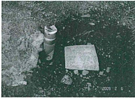
Foto 40: El sondaje AE-DDH-07-34 ha sido cerrado (Plataforma N° 16)
