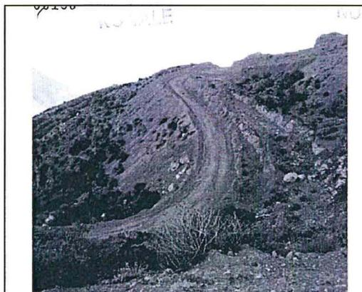
Foto 58: Se observa desprendimiento de material del talud en distintos tramos de la vía de acceso hacia el sondaje AF-IDA-DDH-03 (Plataforma N° 5)
