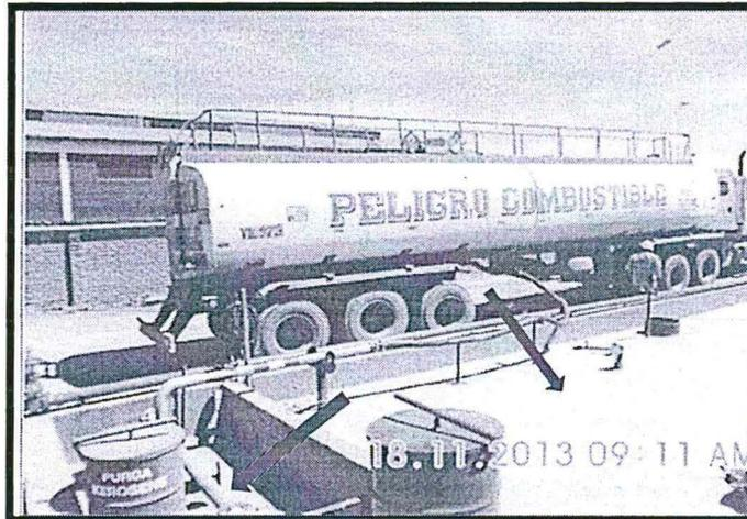
**Fotografía N° 24:** Se evidencia que la zona de recepción de gasolina no cuenta con impermeabilización, que le permita recolectar y recuperar combustible en caso de derrames.
