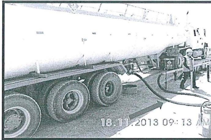
Fotografía N° 25: Se observa que la zona de recepción de Diésel B5, no cuenta con impermeabilización que permita recolectar y recuperar combustible en caso de derrames
