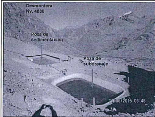
FOTO N° 9. Pozas de sedimentación y subdrenaje, ubicadas al pie del depósito de desmontes del Nv. 4880.
