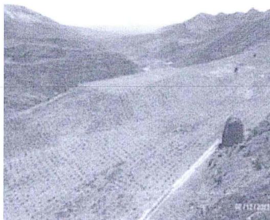
Fotografía N° 37: Antigua Planta de Concreto e instalaciones de concreto.
