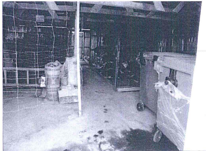
Foto 04: Vista interna de Almacén de residuos.
