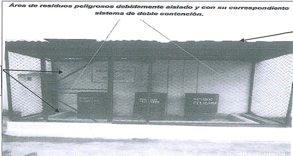
Imagen N°2: Almacén temporal de residuos sólidos peligrosos
