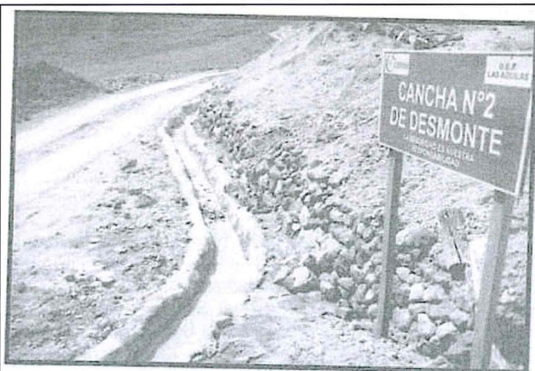
Fotografía N° 03: Depósito de desmonte N° 02, con canal de coronación. Vista hacia el Este.
