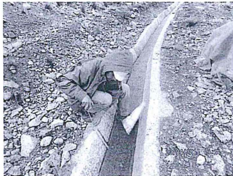
Fotografía N° 128.- Depósito de Desmonte DMPAM-02. Se aprecia parte del canal de coronación de depósito de desmonte DMPAM-02.
