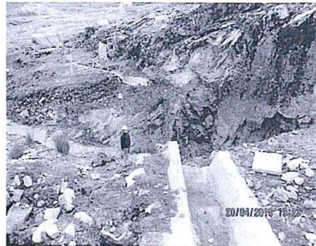
Fotografía N° 127.- Depósito de Desmonte DMPAM-02. Se aprecia parte del canal de coronación del depósito de desmonte DMPAM-02.
