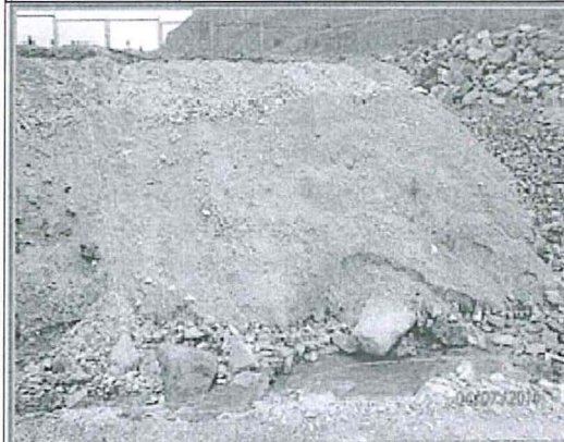
Fotografía N° 26: Hallazgo N° 2: Se observa material de interior de mina deslizado y en contacto con el río Andaychagua, ubicado en las coordenadas (Datum WGS 84) N8702056, E389384.
