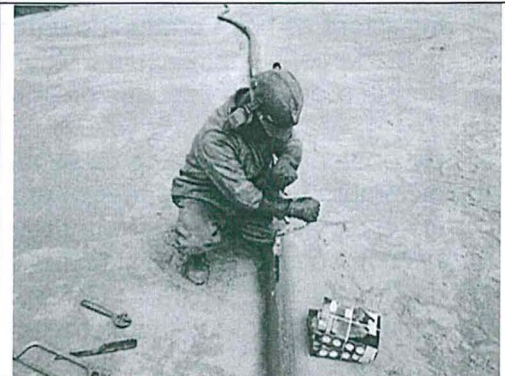
Foto N° 3 Instalación de aspersores en el área de relave grueso cicloneado.
