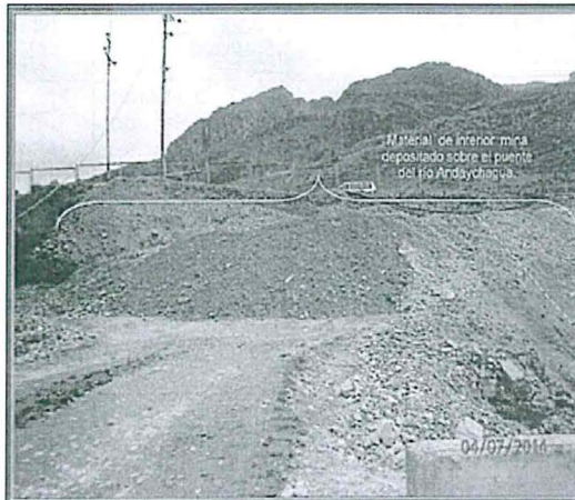
Fotografía N° 24: Hallazgo N° 2: Se observa material de interior de mina (desmorte) acumulado sobre el puente que esta ubicado en la zona de ingreso a de aire limpio CH-946, ubicado en las coordenadas (Datum WGS 84) N8702056, E389384.
