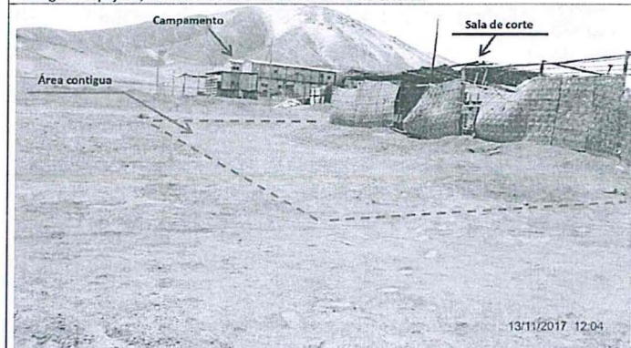
Fotografía 02: Toma de norte a sur del área contigua a la sala de corte. Se observa el área contigua despejada, sin material almacenado ni cerco de esteras.
