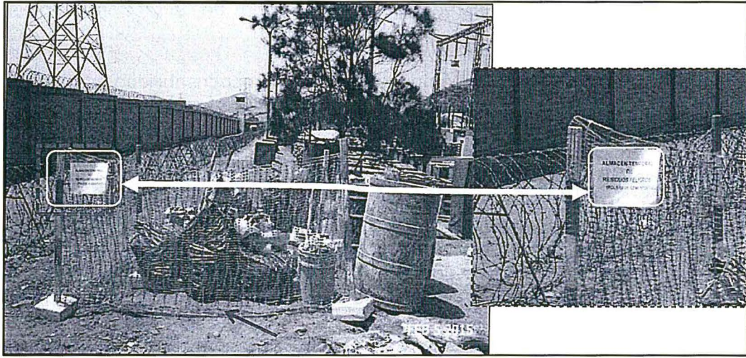
Descripción: Área temporal de almacenamiento de residuos peligrosos en la S.E. Ventanilla Fuente: Informe de Supervisión Directa N° 008-2015-OEFA/DS-ELE
