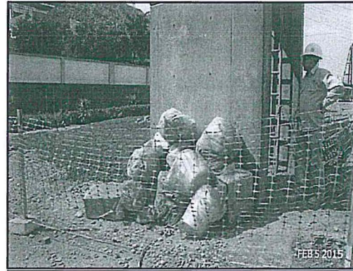
Descripción: Residuos industriales Fuente: Informe de Supervisión Directa N° 008-2015-OEFA/DS-FI F
