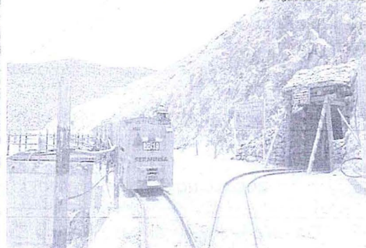
DISPOSICION DE MINERAL DEL CARRO MINERO HACIA LAS TOLVAS DEL MINERAL
