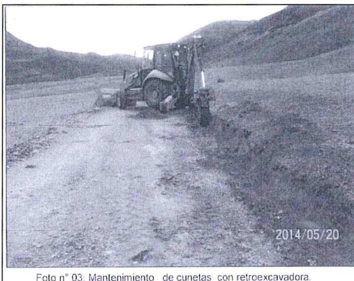
Foto n° 03: Mantenimiento de cunetas con retroexcavadora.
