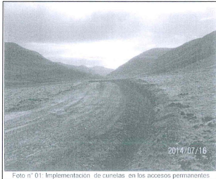
Foto n° 01: Implementación de cunetas en los accesos permanentes
