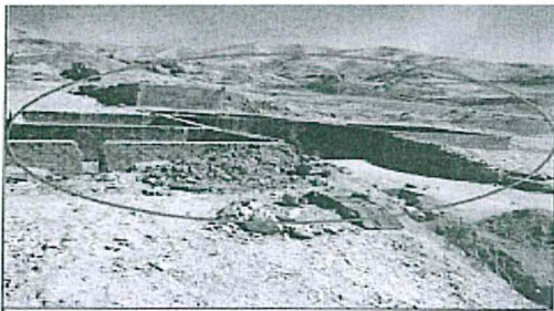
Foto 1: Imagen de Planta Piloto antes de ejecutar la remediación del área..
