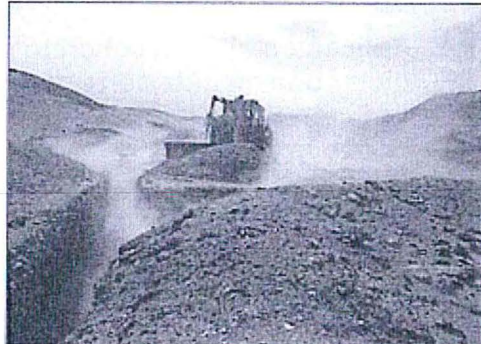
Foto 2: Imagen de ejecución de remediación de trinchera.
