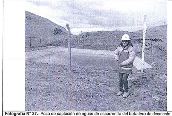
Fotografía N° 37.- Poza de captación de aguas de escorrentía del botadero de desmonte.
