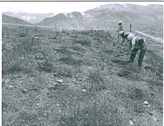
Fotografía N° 16: Plataforma N° 18 durante las actividades de revegetación.
