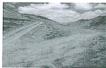
Foto 14: Vista Mirando hacia el Suroeste (proceso de perfilado).
