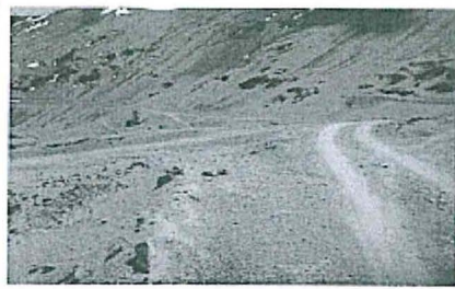
Foto 13: Vista Mirando hacia el Noroeste (proceso de perfilado).
