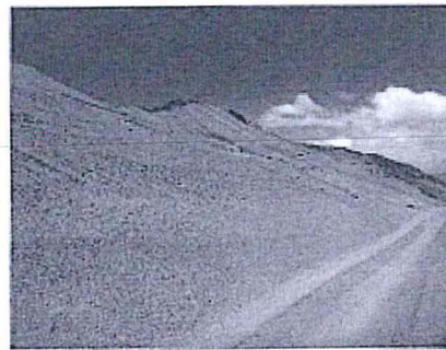
Foto 21: Vista Mirando hacia el Sureste (proceso de perfilado).
