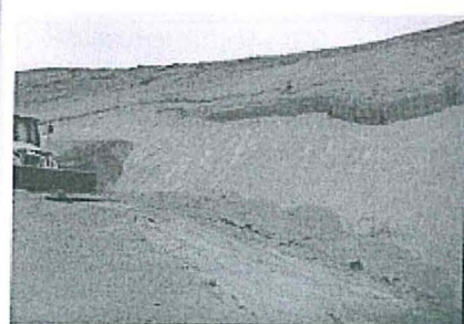
Foto 34: Vista Mirando hacia el este (proceso de perfilado).
