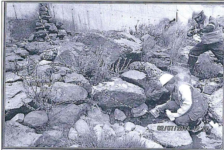
**Fotografía N° 18:** Hallazgo 2, se observa el recorrido del agua que aflora del muro de contención del depósito de relaves remediado Tablachaca, así mismo se observa la coloración marrón clara en el suelo donde escurre este afloramiento, ubicado en las coordenadas WGS84 E 363325, N 8709948.
