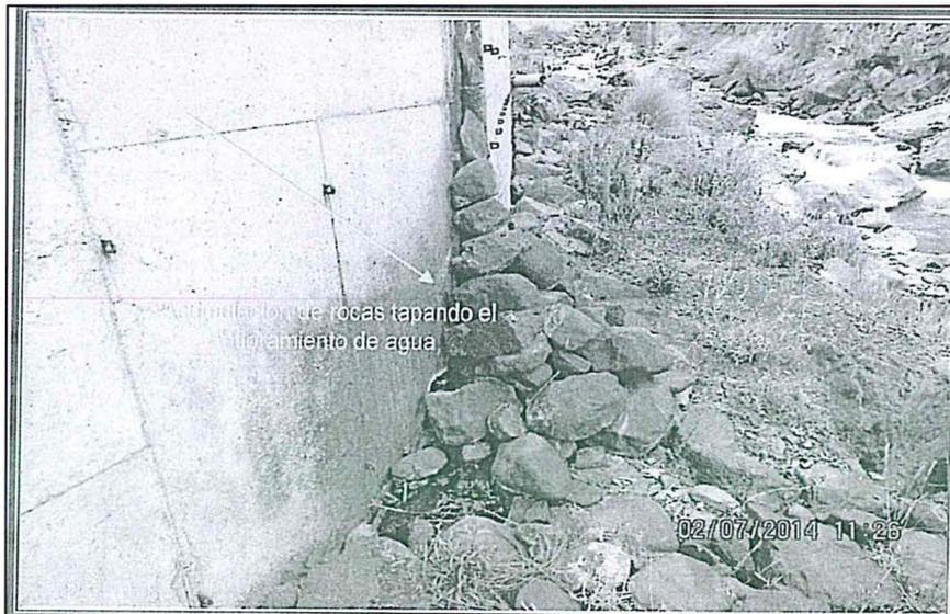
**Fotografía N° 17:** Hallazgo 2, se observa la acumulación de piedras tapando el afloramiento de agua que sobresale del muro de contención de depósito de relaves remediados Tablachaca ubicado en las coordenadas del lugar UTM (Datum WGS 84) E 363325, N 8709960.
