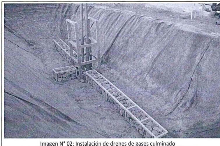
Imagen N° 02: Instalación de drenes de gases culminado
