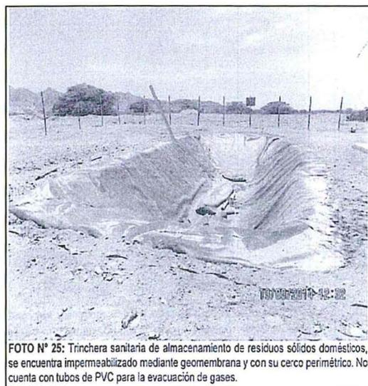
FOTO N° 25: Trinchera sanitaria de almacenamiento de residuos sólidos domésticos, se encuentra impermeabilizado mediante geomembrana y con su cerco perimétrico. No cuenta con tubos de PVC para la evacuación de gases.
