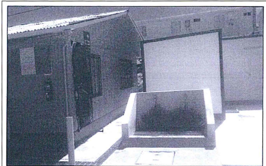
Foto N° 3: Lavadero de botas N° 3 y canaletas que generan el efluente.
