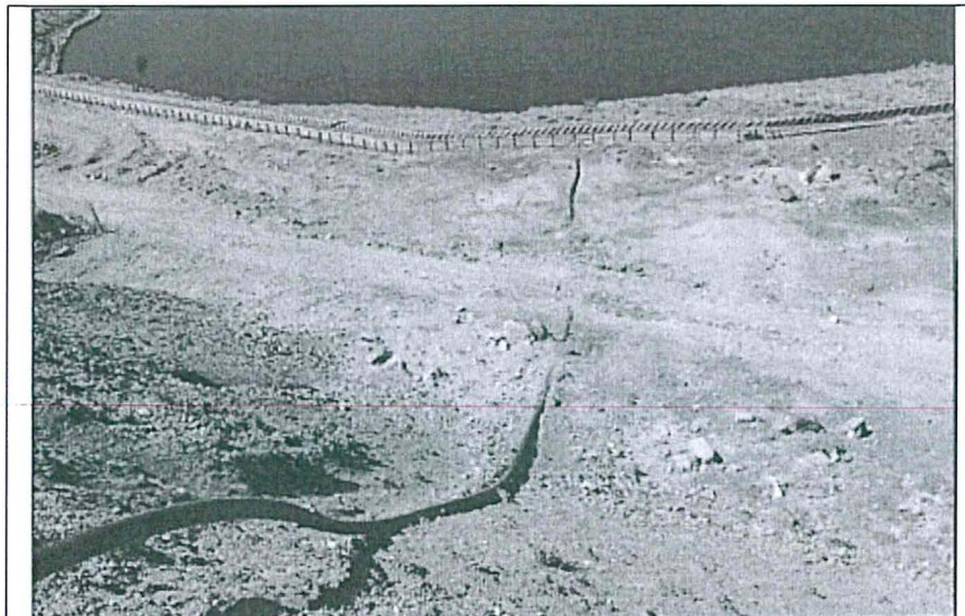
Foto N° 1: Instalación de tubería de 45 metros de HDPE DE 4" que deriva el agua hacia el canal de coronación.
