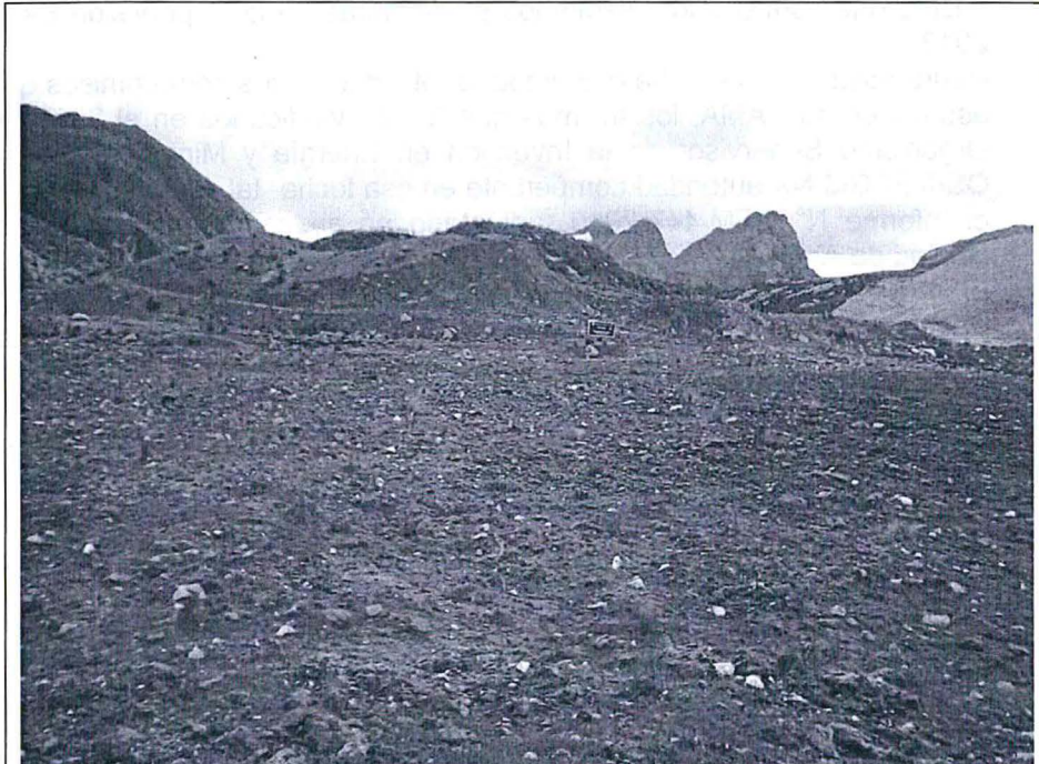
Fotografía N° 22. Depósito De Relaves Nieve Ucro I.- Ubicado en las coordenadas Datum WGS84, Zona 18: 310157E, 8845223N, Cota: 4547. Se aprecia con una cobertura de topsoil, y reforestado con ichu.
