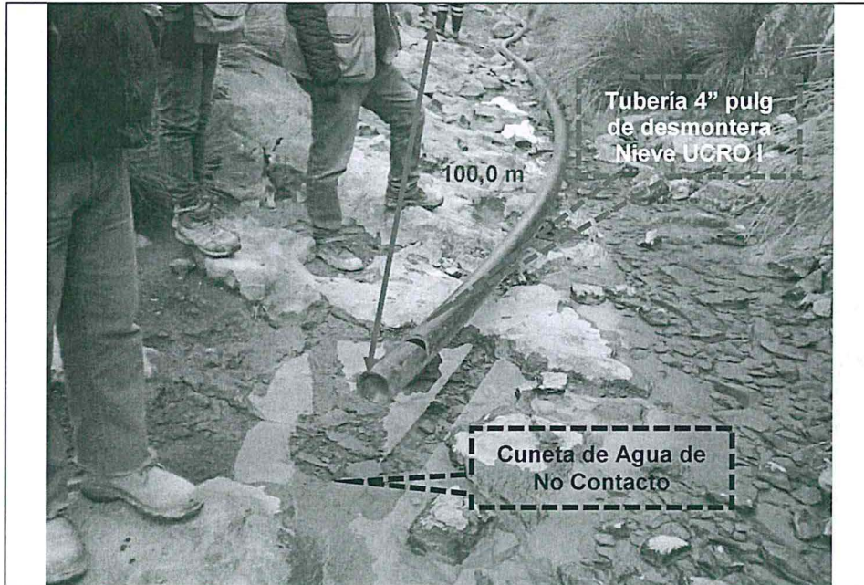
Fotografía N° 27. En la vista, se aprecia la tubería de 4" pulgadas luego de recorrer 1020 m, desde la desmontera Nieve Ucro I, llegando a la coordenada (WGS84) ZONA (18), 310062E, 8845391 m, COTA: 4564.
