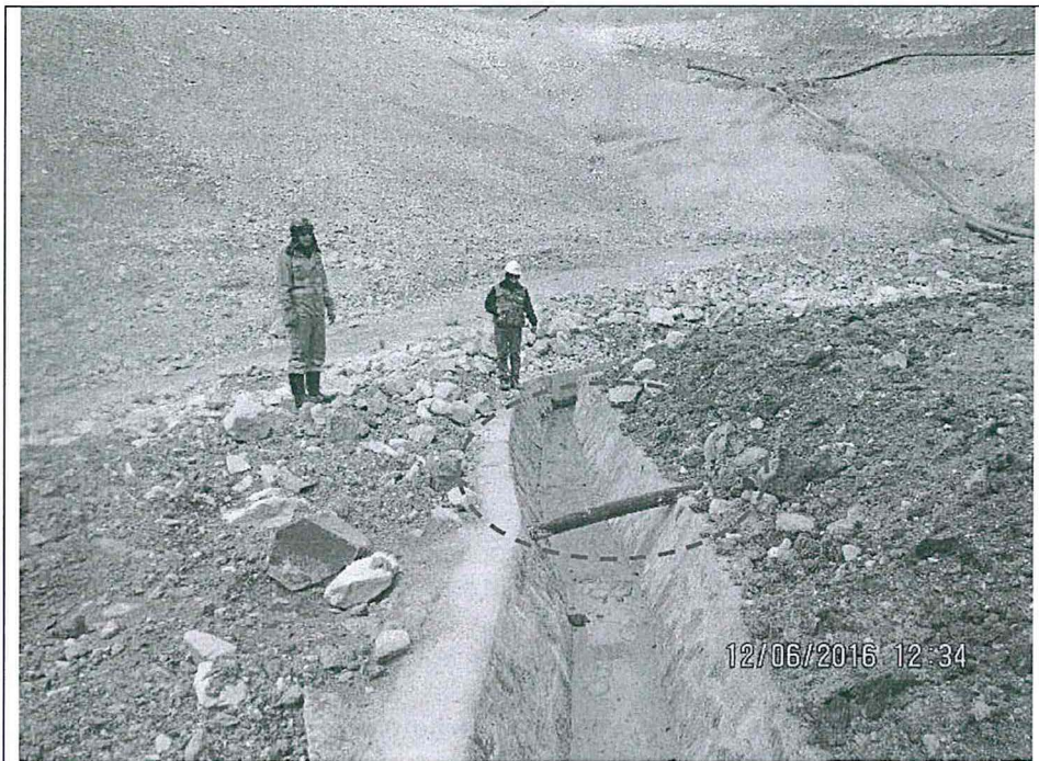
Fotografía N° 109. Punto de muestreo PMW-01/EAR. (...) En esta fotografía se observa el canal de coronación del depósito de relaves Nieve Ucro I sin descarga.
