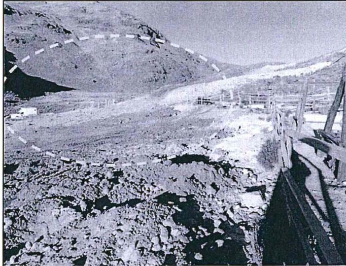
Fotografía N° 36. Vista del nivelado del terreno en las excavaciones al pie de las excavaciones N° 2, acción tomada de inmediato por el titular minero.
