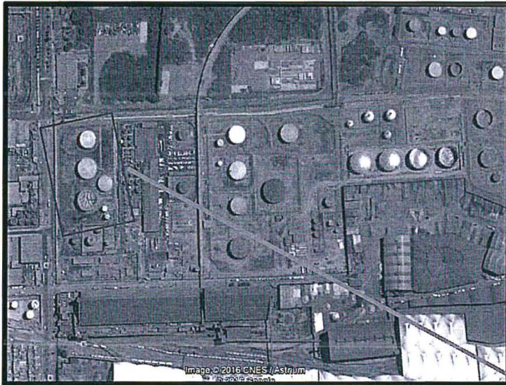
Elaboración: Dirección de Fiscalización, Sanción y Aplicación de Incentivos Fuente: Google Earth.
