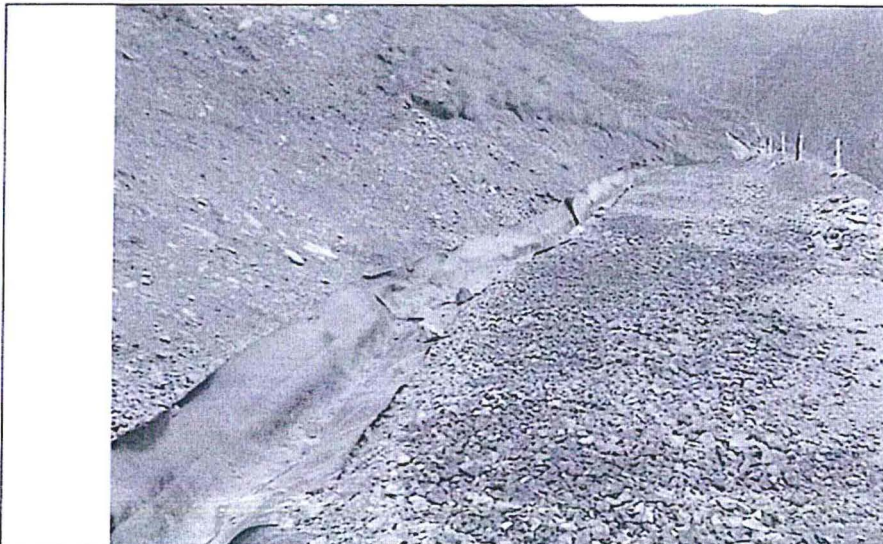
Fotografía N° 92.- HALLAZGO 01: El administrado realizó la limpieza del canal, observándose que este se encuentra libre de material. Levantándose el presente hallazgo.
