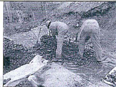
Foto N° 21. Vista de la separación y cribado del cascajo
