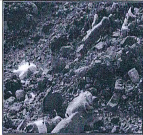
Fotografía N° 106.- Existen materiales expuestos, tales como bolsas, envases de plásticos, llantas, entre otros, en el relleno industrial. Se aprecia que los materiales dispuestos sólo son coberturados o tapados con tierra.
