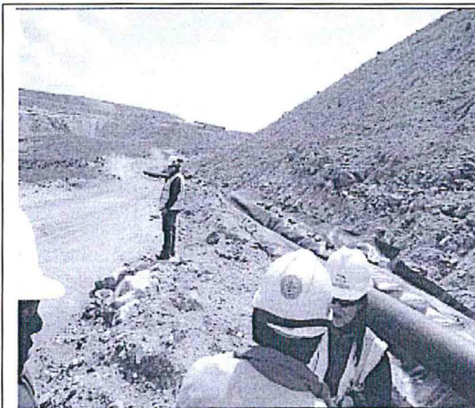
Fotografía N° 40.- Supervisor del OEFA verificando el punto inicial del canal de derivación de aguas superficiales frente a la zona de la planta concentradora.
