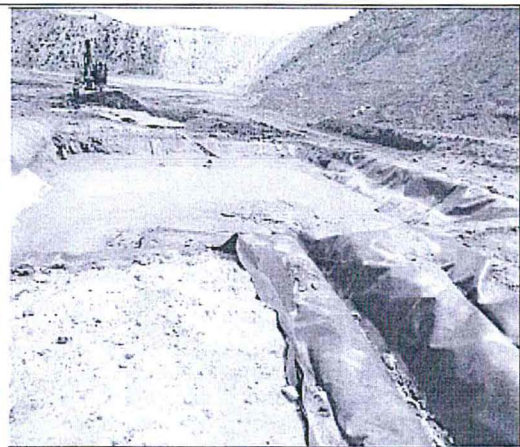
Fotografía N° 41.- Poza de recolección de aguas superficiales del canal de derivación en la zona de la planta concentradora en proceso de expansión.
