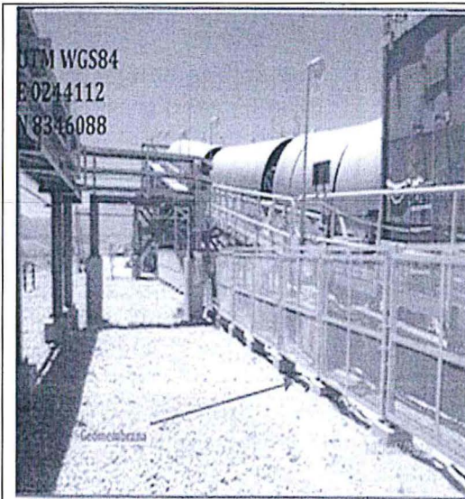
Foto 2.7.- Vista panorámica del tramo inicial de la faja (chancado primario), se puede apreciar el sistema de geomembrana bajo la faja y en entorno a este se encuentra limpio.
