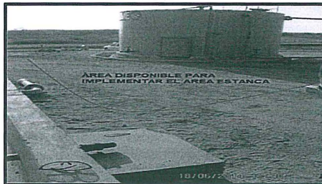
Fotografía N° 19 Descripción: Vista de Tanque de almacenamiento de crudo de la Batería 321, obsérvese disponibilidad de terreno para la implementación de un área estanca.
