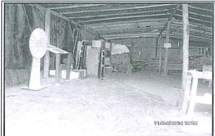
Fotografía 75: Hallazgo 6 – Vista del Taller de Reutilización en cuyo interior se ha implementado indebidamente un Almacén de Productos Químicos
