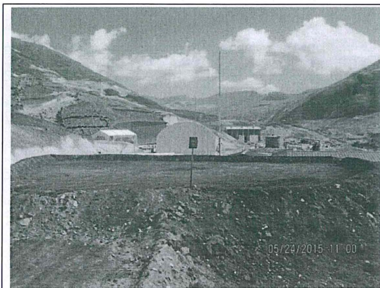
Área del DMO 5, con la señalización. Adicionalmente se retiró la maquinaria del lugar.
