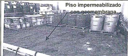
FOTO N° 45 Almacén de lubricantes y productos químicos dentro de un sistema de contención de derrames protegida con geomembrana en el almacén central de Pacif en la Caleta La Cruz. Coordenadas UTM – WGS 84 Zona 17: 0545565 E, 9598148 N.
