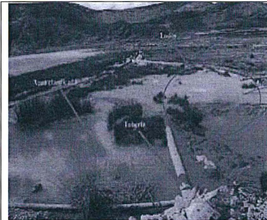
Fotografía N° 73: Hallazgo 5, Supervisión 2013: Parte superior de la laguna Naticocha Norte donde se observa el agua clarificada proveniente de la poza de secado de lodos. Además se observa lodos acumulados y tuberías.
