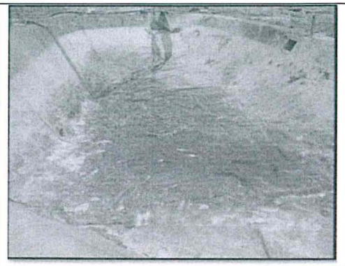
Foto 6: Pozas de tratamiento limpias
