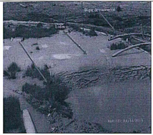
Fotografía N° 74: Hallazgo 6, Supervisión 2013: Parte superior de la laguna Naticocha Norte donde se observa el área verde (pajonal) lleno de lodos. Además se observa un dique de contención impermeabilizado con geomembrana y tuberías.
