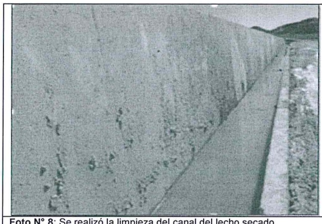
Foto N° 8: Se realizó la limpieza del canal del lecho seco
