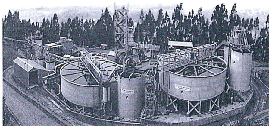
Fotografía N° 1: Vista general de la Planta de tratamiento Pucauran
