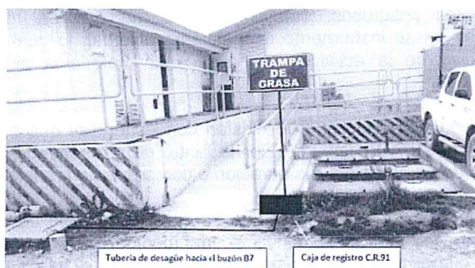
Imagen N° 9: Zona de la trampa de grasa
