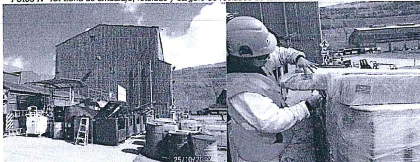
Fotos N° 13: Zona de embalaje, rotulado y carguío de residuos de taller de mantenimiento Yanacocha Norte.
