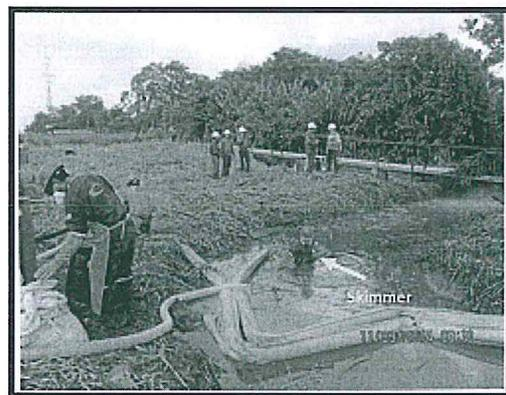
Foto N° 6: Personal de contingencia desarrollando actividades de recuperación de diésel sobrenadante utilizando el Skimmer (color rojo señalado), también puede verse la barrera de contención instalada y la extensión de suelo impactado.
