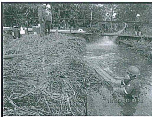
Foto N° 3: Actividades de limpieza del agua de canal, lavado de las riveras y recuperación de hidrocarburos derramado en la fuente de agua.
