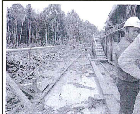
Foto N° 07: Se observa la parte frente del área lateral (aprox. 28 m. x 5 m.) de la Poza 1502 impactada por el derrame de recortes y lodos de perforación (migración de sólidos suspendidos).
