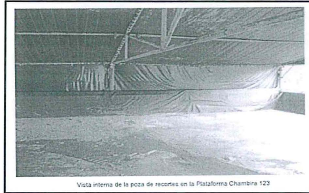
Vista interna de la poza de recortes en la Plataforma Chambira 123
