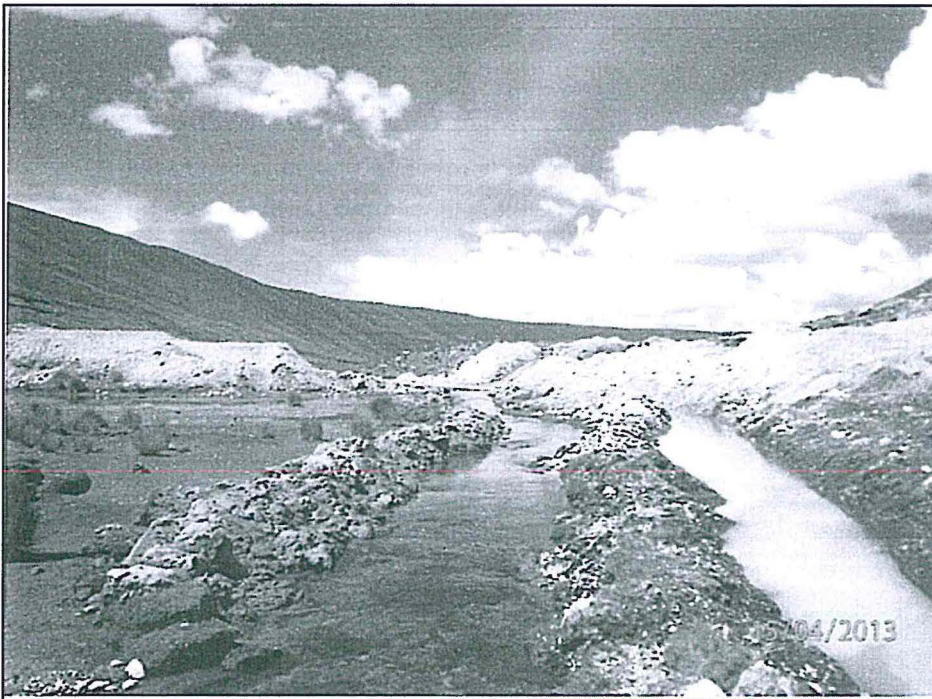
Vista 15. Obras de desvío provisional de las aguas en la Presa Calzada, utilizando tierra
