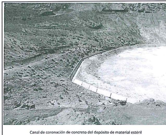
Canal de coronación de concreto del depósito de material estéril
