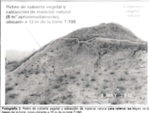
Fotografía 2. Retiro de cubierta vegetal y extracción de material natural para rellenar las bases de la torre, zona ubicada a 12 m de la torre T-198
