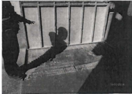
Fotografía HALL N° 2: Se observa la tolva con rejilla a nivel del suelo por donde caen los granos de maíz para ser conducidos mediante fajas subterráneas hacia los silos de almacenamiento.
