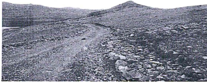
Fotografía N° 38. Otra vista del Acceso principal que conduce a los componentes. Se observó la trayectoria del acceso que conduce a los componentes con una longitud de 4000 metros aproximadamente. En dicha trayectoria se observó cortes de talud, con el material de corte dispuesto en la parte inferior y laterales.
