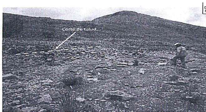
Fotografía N° 9. Vista del área de la Plataforma N° 11. Plataforma ejecutada. Ubicado en las coordenadas UTM WGS 84 E. 375781 N. 8393159. En dicha área se observó corte en el talud, presentaba un dado de concreto de sondaje con una tubería de PVC y con escasa vegetación.
