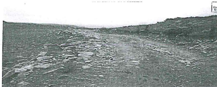
Fotografía N° 37. Otra vista del Acceso principal que conduce a los componentes. Se observó la trayectoria del acceso que conduce a los componentes con una longitud de 4000 metros aproximadamente. En dicha trayectoria se observó cortes de talud, con el material de corte dispuesto en la parte inferior y laterales.
