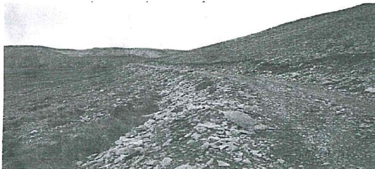
Fotografía N° 36. Otra vista del Acceso principal que conduce a los componentes. Se observó la trayectoria del acceso que conduce a los componentes con una longitud de 4000 metros aproximadamente. En dicha trayectoria se observó cortes de talud, con el material de corte dispuesto en la parte inferior y laterales.
