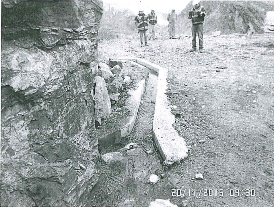
FOTO N° 68: Vista del canal de concreto que conduce el agua de mina de la bocamina Mónica hacia un sistema de tratamiento.
