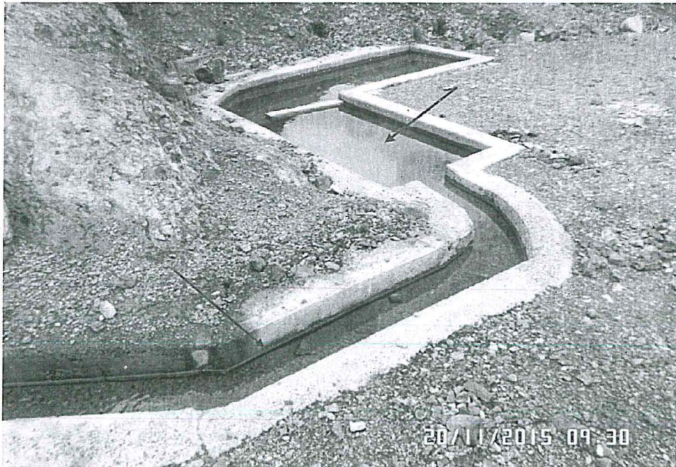
FOTO N° 69: Vista de canal de concreto y el sistema de tratamiento de agua de mina.
