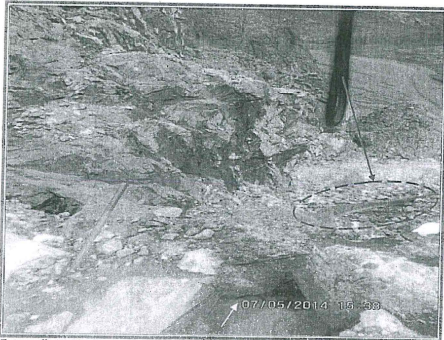
Fotografía N° 10: Descarga de las pozas de sedimentación de la bocamina Sabrina. Nótase una tubería de HDPE que sale de la poza y hace que el agua caiga sobre uno de los costados del cono donde se encuentra ubicada, la bocamina.
