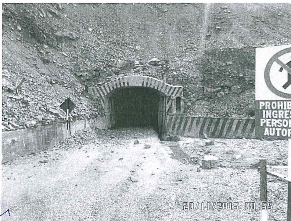
am cel FOTO N° 63: Vista de la bocamina Crucero 2000, ubicada en coordenadas UTM 8913894N 268816E Datum WGS-84, zona 18.
