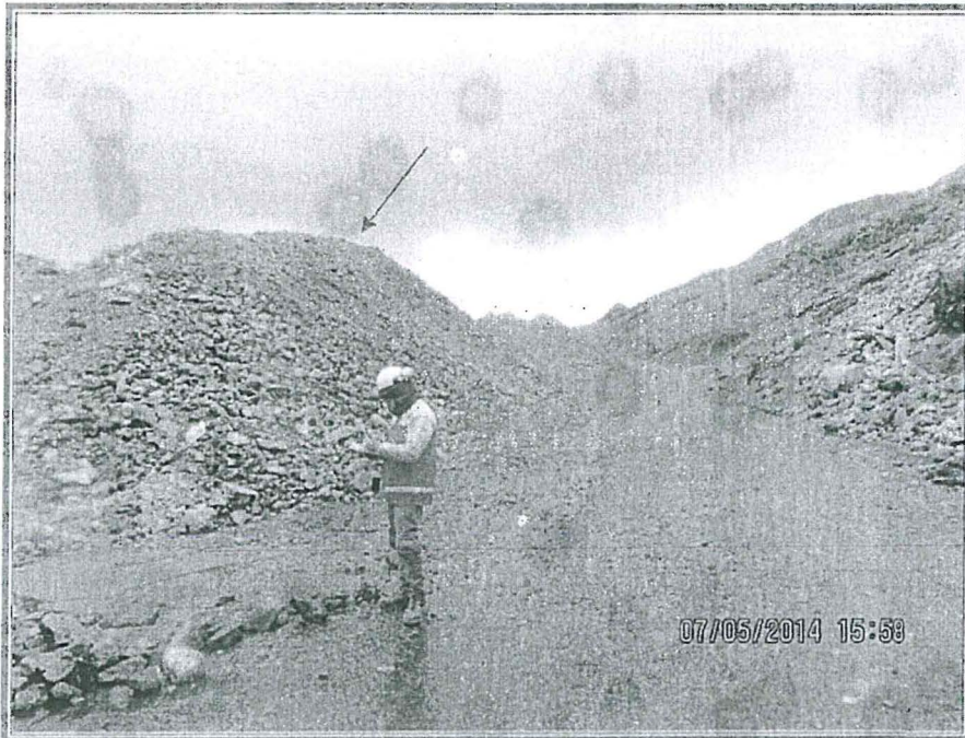
Fotografía N° 16: Vista del Depósito de desmonte N° 1. Nótese que las aguas de escorrentías entran en contacto con dicho depósito y discurren por un costado del acceso.
