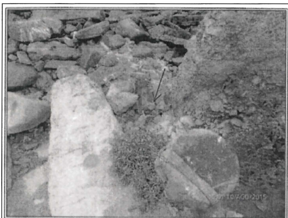
Foto 13. Vista de la abertura del emisor submarino por donde fluyen parte de los efluentes a la orilla de playa
