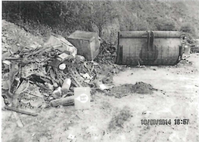
Fotografía N° 222.- El depósito temporal de residuos sólidos del sector Ex Oficinas Generales, carece de identificación; los residuos de chatarra, caja de agua, cilindros, tubos metálicos, cables, baldes de pintura se encuentran en un mismo lugar y colocados directamente en el suelo; tampoco existen estructuras hidráulicas que capten y deriven el agua de lluvia.
