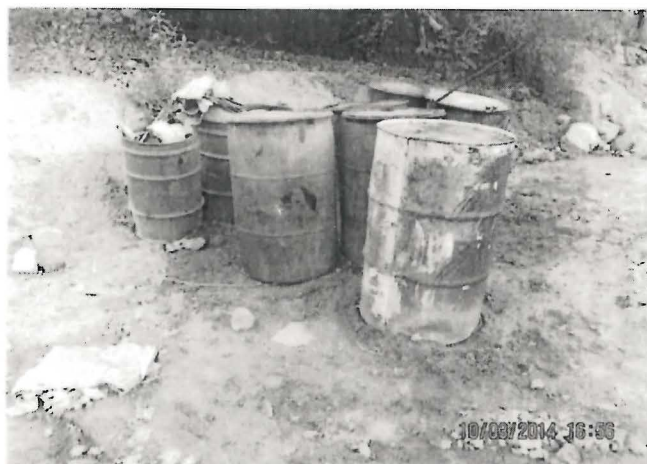
Fotografía N° 221.- En el depósito temporal de residuos sólidos del sector Ex Oficinas Generales, los cilindros metálicos y de plásticos se encuentran en un área sin identificación y estaban colocados directamente sobre el suelo; tampoco existen estructuras hidráulicas que capten y deriven el agua de lluvia.
