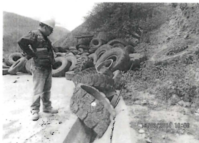
Fotografía N° 215.- En el depósito temporal de residuos sólidos del sector Ex Laboratorio, las llantas usadas se encuentran fuera de la losa de concreto y el canal de coronación se encuentra lapado por las mismas.
