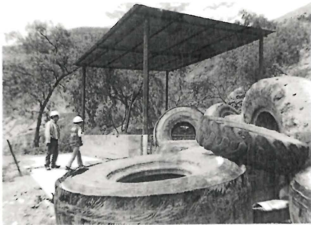
Fotografía N° 217.- Losa de volatilización, ubicado próximo a la losa donde se almacenan las llantas del depósito temporal sólidos denominado Ex Laboratorio, registrado en campo con coordenadas UTM datum WGS 84: 8 160 421 N, 566 120 E y 2 137 msnm.
