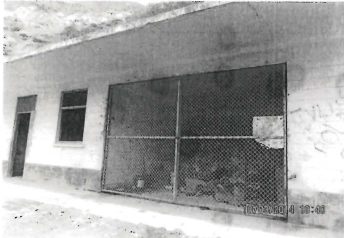
Fotografía N° 207.- Ambiente sin identificación, techado, enrejado y con piso de concreto, ubicado en sector Ex Laboratorio donde se almacena temporalmente cilindros y materiales impregnados con hidrocarburos.
